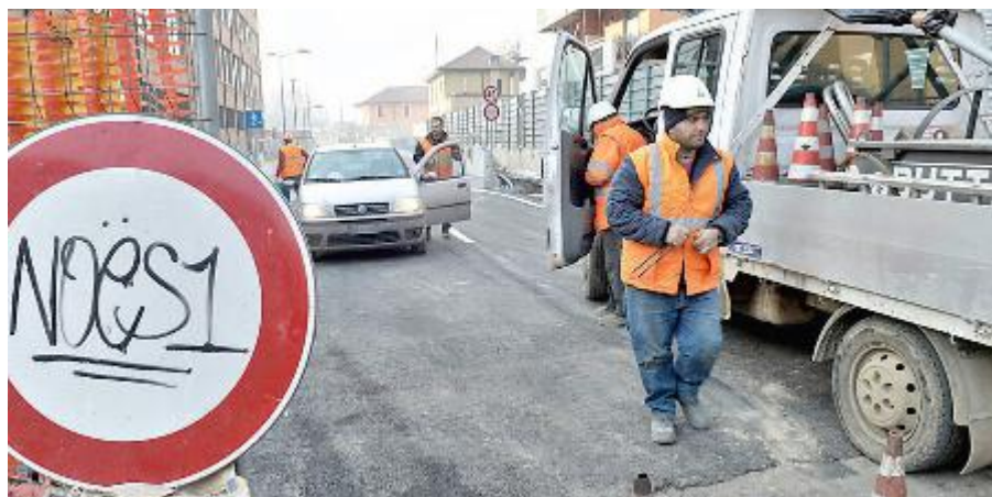
CANTIERI Il Comune ha un piano di lavori di manutenzione straordinaria
